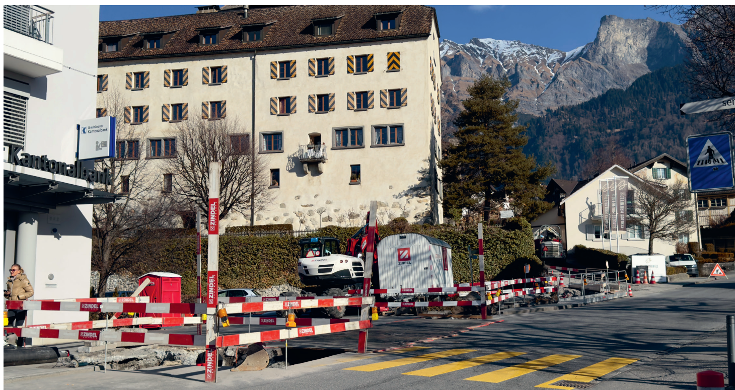
Baustelle Erschliessung Schlossareal
